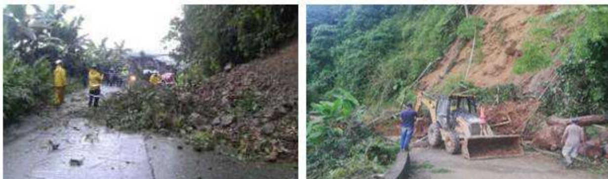
Ilustración 81. Derrumbe en la vía Manizales-Caldas y Neira-Aranzazu
